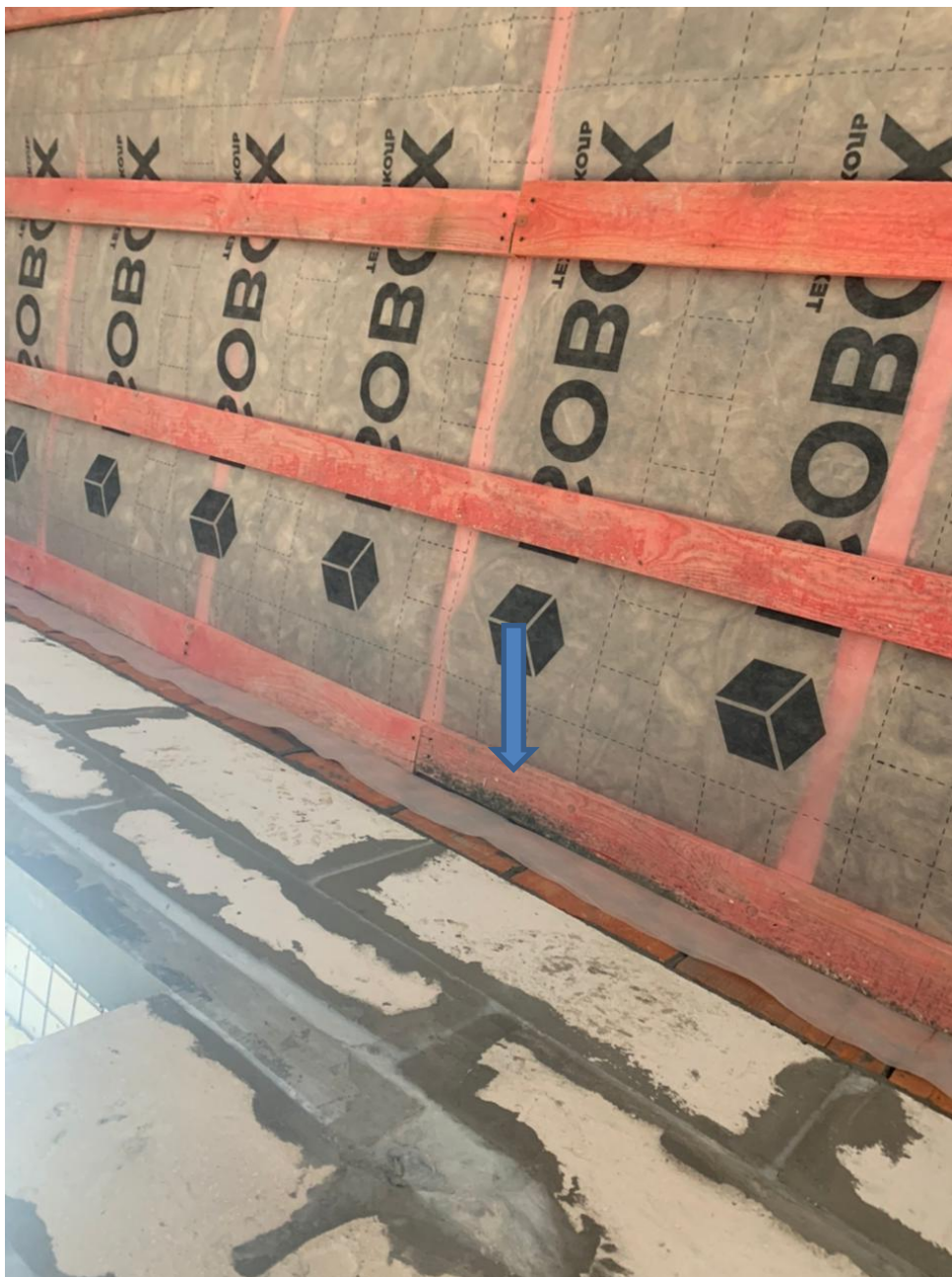
Пиломатериалы имеющие следы биоповреждений.
