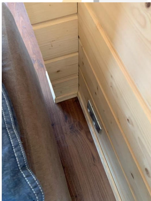
Места с теплотерями снизу по углам.
