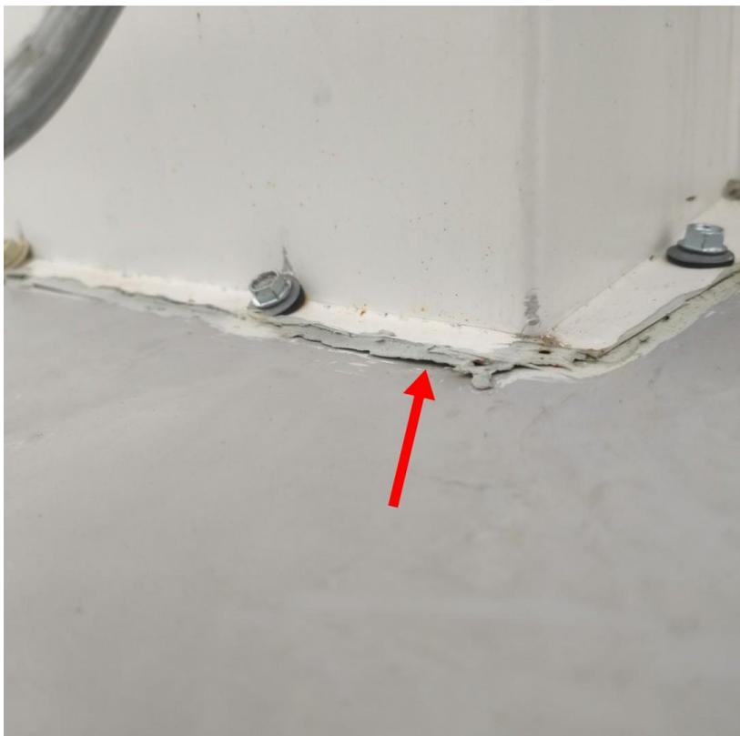
3. Не загерметизированы стыки кровельных сэндвич панелей. 60-70% стыков.
